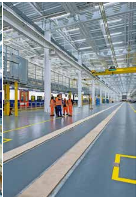
Arbeiten auf drei Ebenen: Von unten, auf Gleishöhe und von der Empore aus auf Dachhöhe. Drei 150 Meter lange Kompositionen haben Platz. Enzo Lopardo
